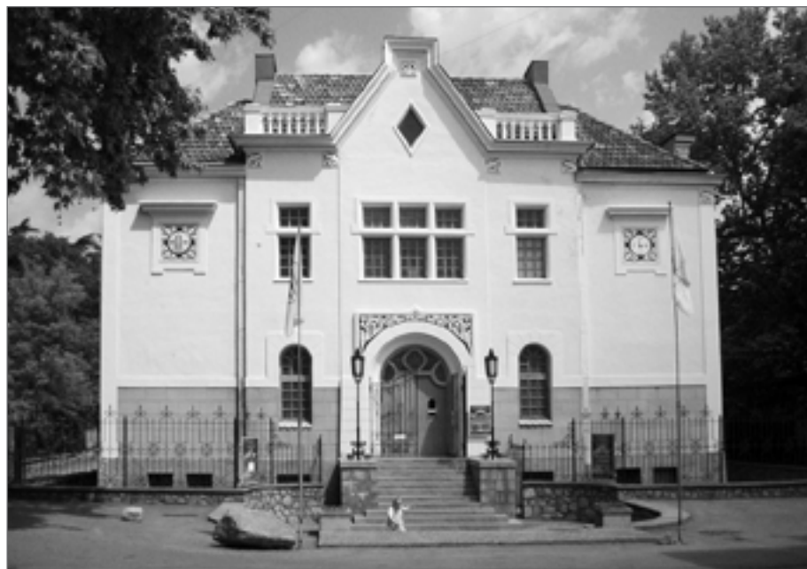
Здание электростанции в Ливадии. Арх. Гуцин. Фото Г. Корневой. 2010 г.
