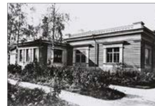
Здание дворцовой электростанции в Гатчине. Фотография 1930 г.
